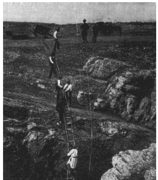
Descente aux échelles du 1 er puits
